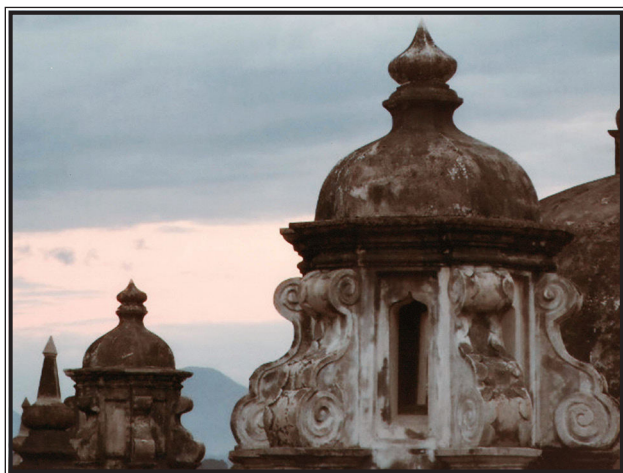
Dos cúpulas de la cubierta (siglo XVIII).
