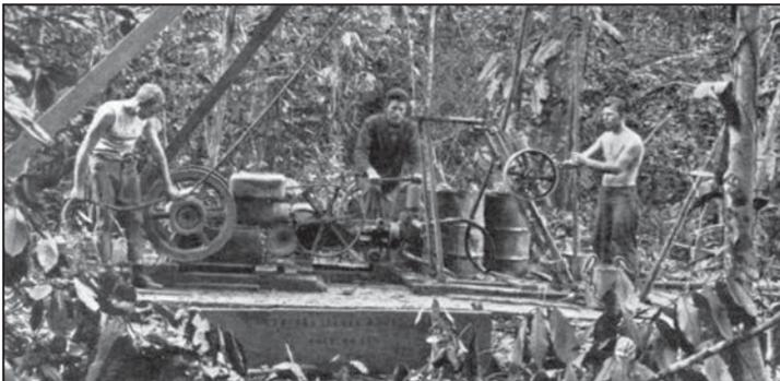
Ilustración 1. Ingenieros del *Army* perforando el subsuelo en la selva del San Juan, obteniendo datos para la construcción del canal. Fuente: *National Geographic Magazine*, mayo 1932.
