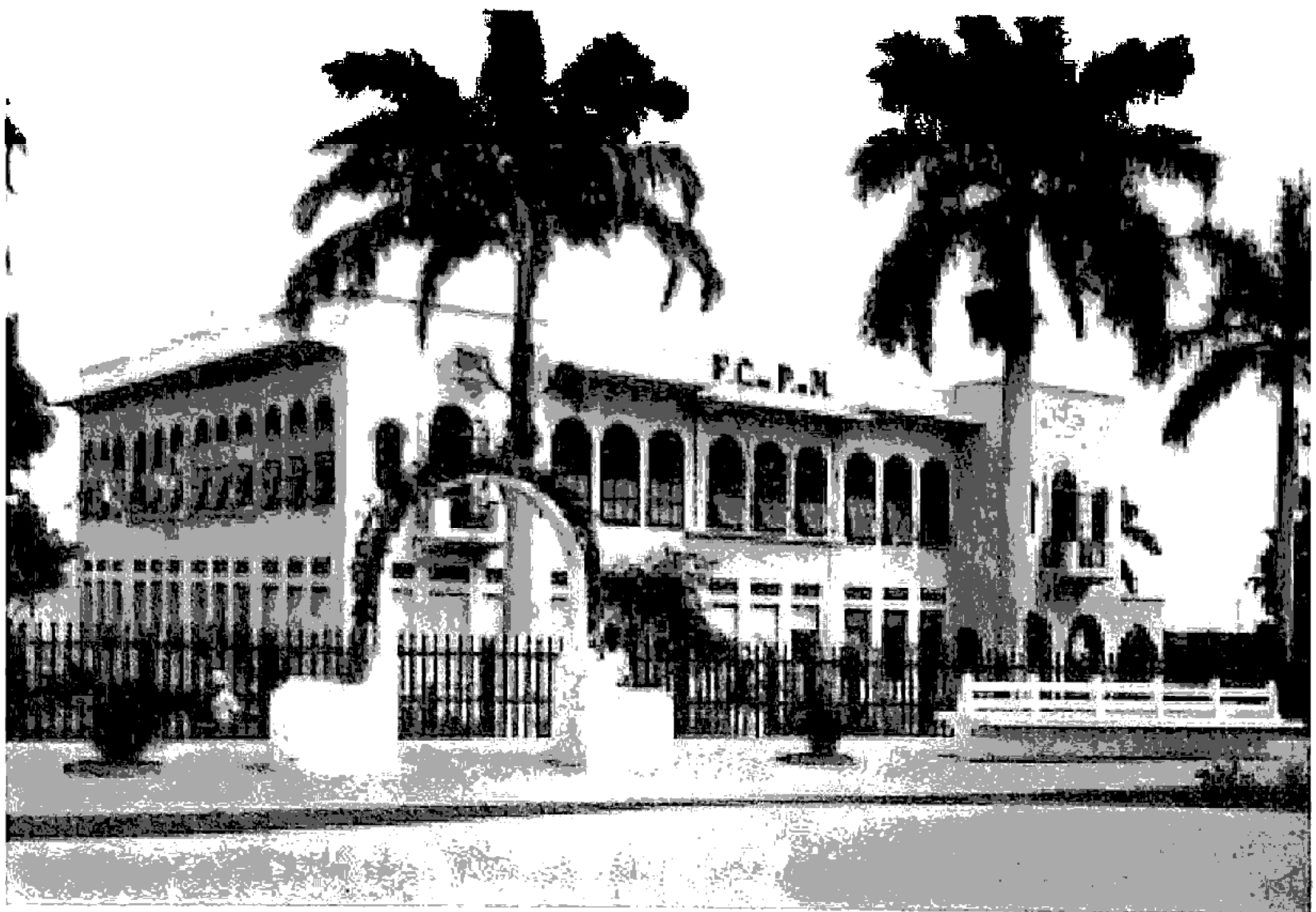
Edificio del Ferrocarril (1941). Foto de A. Díaz F.
