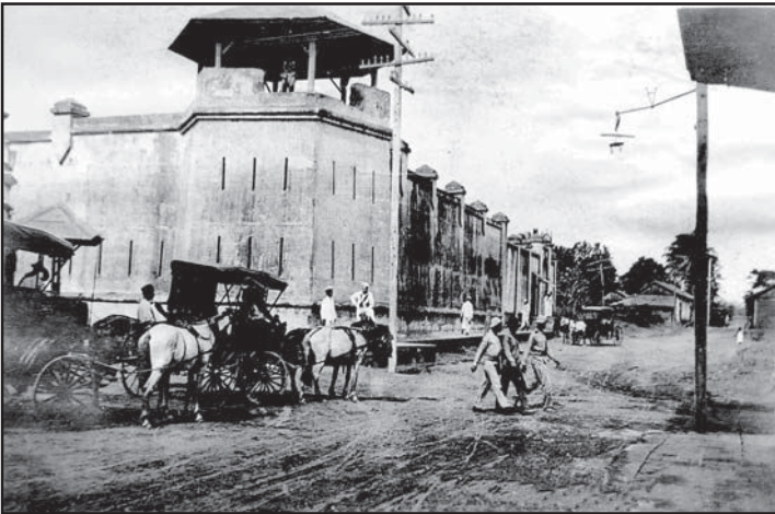
El Hormiguero (1932). Cárcel construida por los marinos estadounidenses. Dejó de funcionar en julio de 1979
