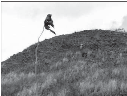
Fig. 10. Cerro El Arenal. En algunos casos los indígenas construyeron muros de contención con piedras y argamasa para crear un acceso hasta la cima del cerro. Durante las intensas lluvias del huracán Mitch, el sitio fue destruido parcialmente.
