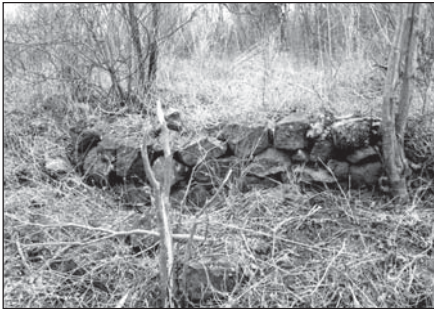
Fig. 7. Muros de piedra que sirven de basamento para construcciones de bajareques y techos de paja. Estos muros tienen una altura de unos 40 a 50 cms.
