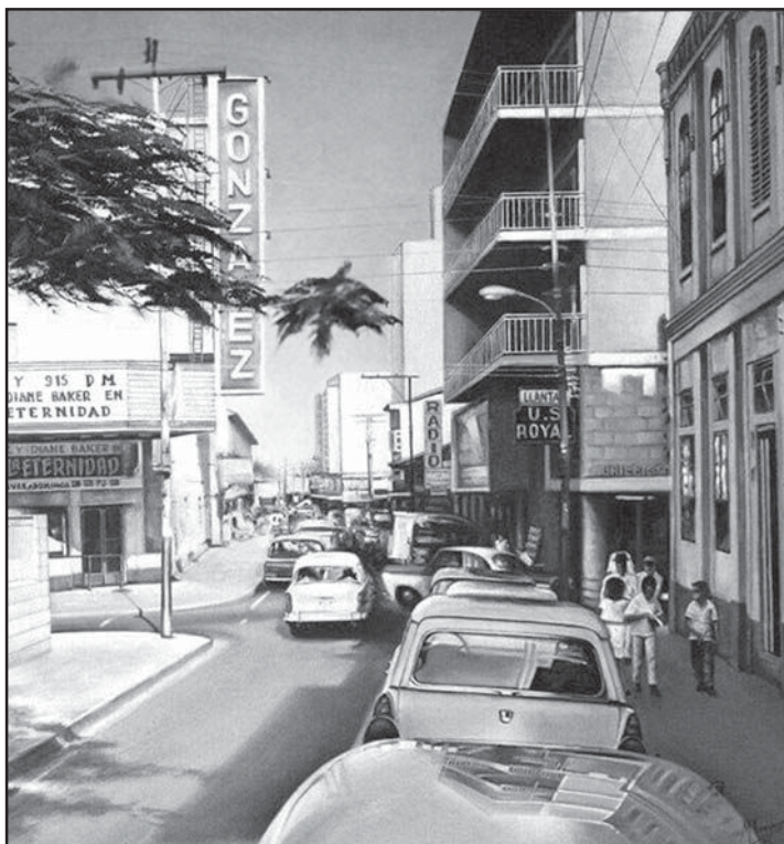
Vista del cine González, colindante al este con el Gran Hotel, sobre la entonces calle Momotombo. Ambos edificios aún persisten. La escena corresponde a 1963 o 1964.
